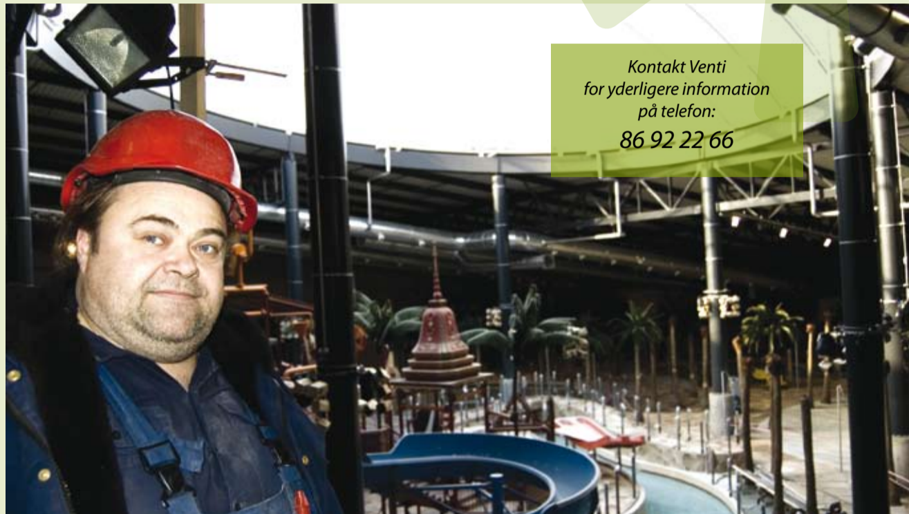
Peder, som er montør hos Brøndum A/S, er meget tilfreds med samarbejdet med Venti.
