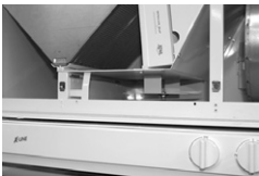
Spjæld ved sommerdrift Spjældet sættes til vinterdrift ved at trække låsen væk fra en selv.
