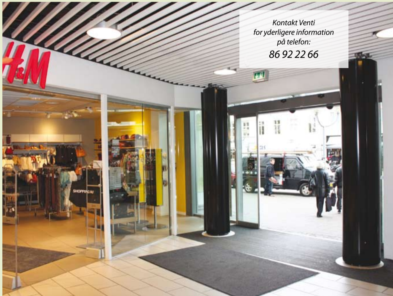
Afskærmningsmæssigt er stående lufttæpper en fordel, fordi der er mest tryk på lufttæppet ved gulvet, hvor den kolde luft blæser ind.
