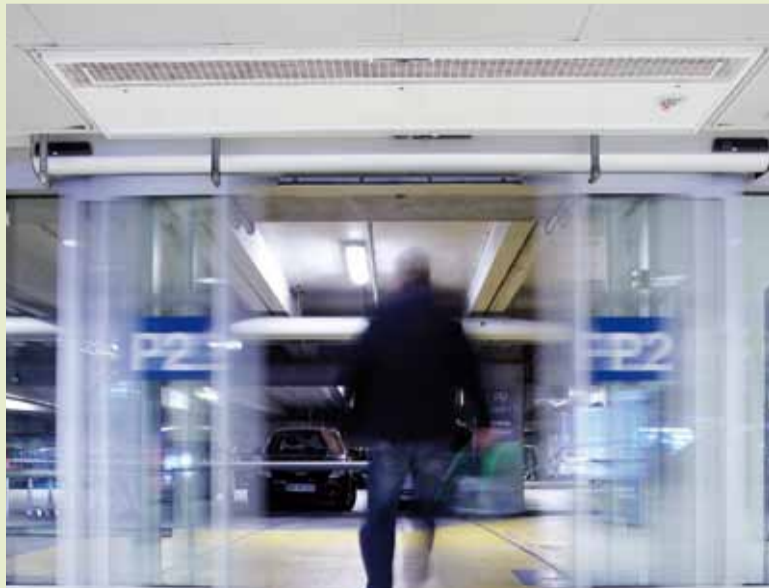
Udgangen til de tre parkeringsdæk under Bruun's Galleri har alle fået nye lufttæpper fra Venti med de rette dimensioner.
