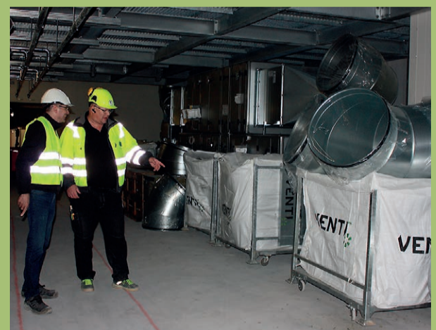
Hygiejnekravene ved sygehusbyggeri er meget høje. Derfor emballeres komponenter til DNU straks efter, de er produceret. Projektleder Kim Lauridsen fra GK Danmark A/S (th) er meget tilfreds med, at Venti lever op til kravene, hvilket letter hele arbejdsprocessen.
