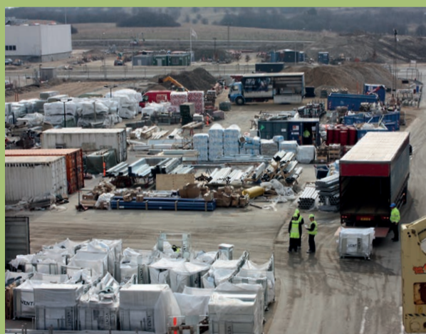
Rørbure med komponenter fra Venti leveres direkte til byggepladsen. Da der dagligt ankommer over 200 lastbiler, kræves det at leverancerne er præcise. Venti håndterer alt omkring logistikken, herunder bookning af leverancer.
